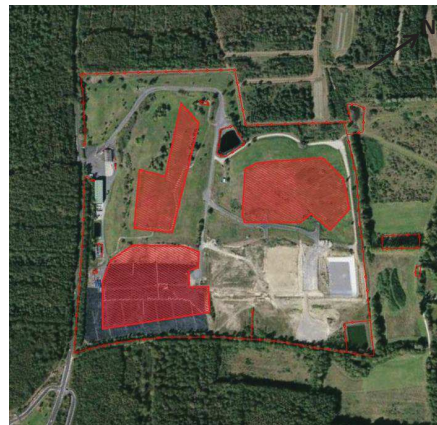
Zone d'implantation des panneaux photovoltaïques
