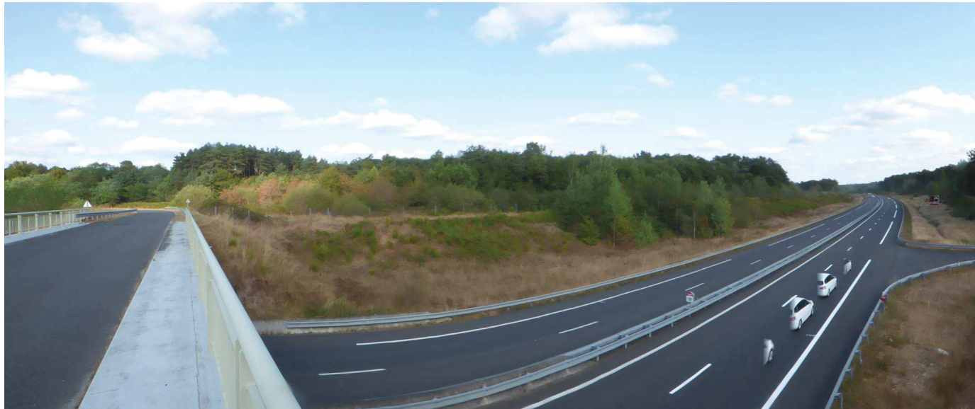
Photo n°14 : Depuis le pont passant au-dessus de l'A85 à l'ouest du projet, les masses boisées dominent le paysage.
